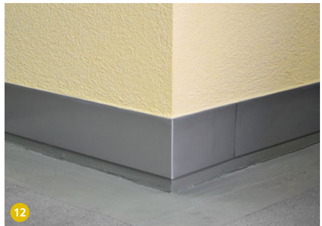
12 Deckputz und Farbe auftragen.
