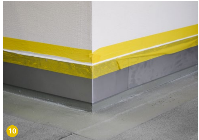
10 Montage des Sockelschutzblechs.
