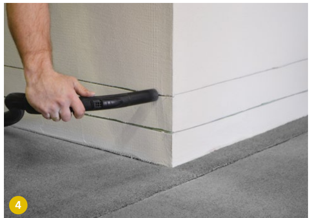
4 Stecknut und Kapillarschnitt sind nach dem Erstellen staubfrei zu halten (Staub z. B. mit Druckluft oder Staubsauger entfernen).
