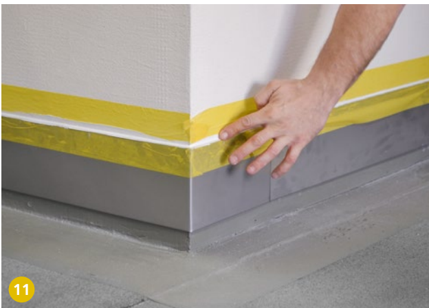
11 Abglätten und Entfernen des überschüssigen Füllstoffs (keine zusätzliche Fuge erstellen).
