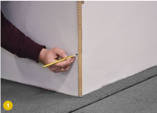
1 Anzeichnen der Stecknut und Kapillarschnitthöhe.
