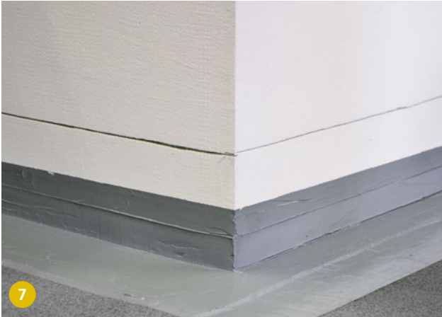
7 Nach erfolgter Aushärtung des Schutzanstrichs Schutzblech an Gebäude anpassen.
