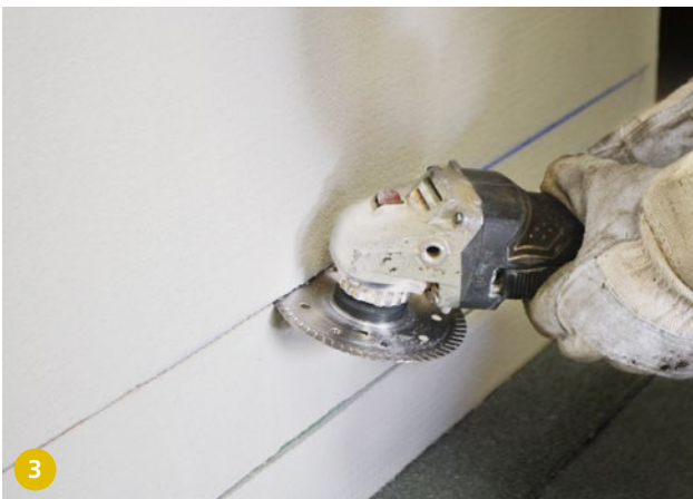
3 Stecknut und Kapillarschnitt mit geeigneten Hilfsmitteln ausführen.
